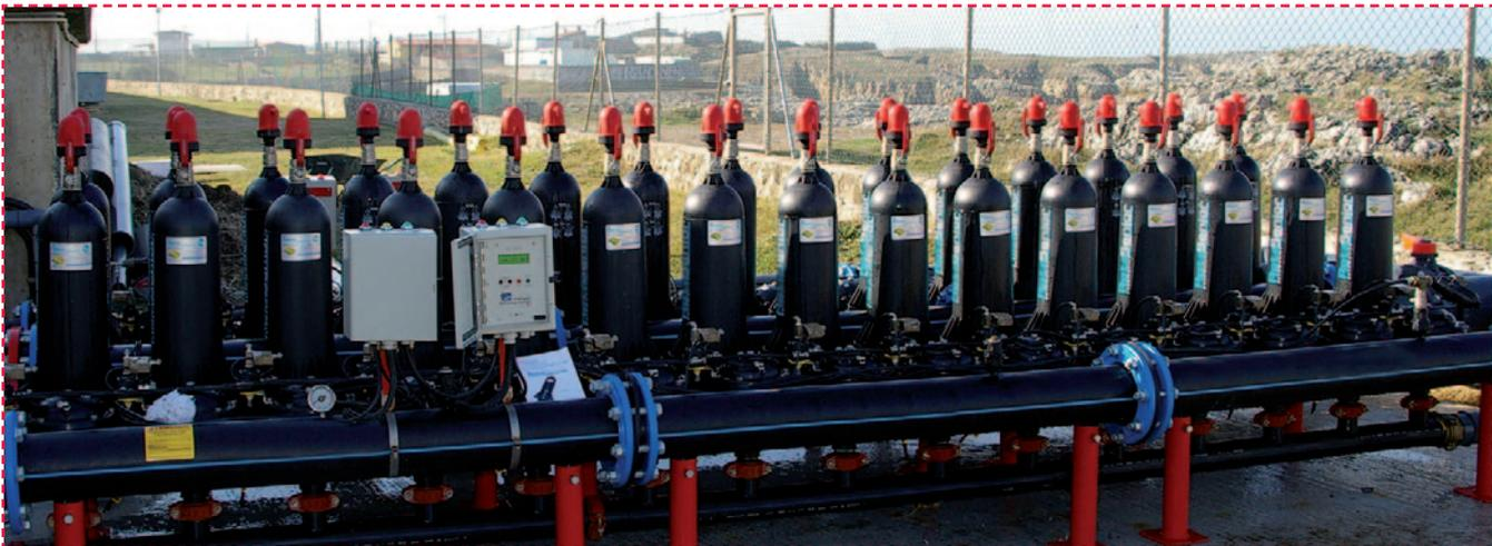
La vanne trifonctionnelle VYR-39 est conçue pour résister les conditions de travail les plus rigoureuses et pour évacuer efficacement l'air accumulé dans les tuyaux du réseau hydraulique.
